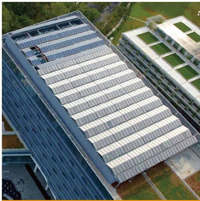
シンガポールに初のソーラー空調 【写真提供】City Developments Ltd
