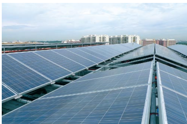
最高グリーン建築基準を満たすプロジェクトのその一つ「Tampines Grande」。屋上に784平方メートルにわたって太陽電池パネルが設置されている 【写真提供】City Developments Ltd
