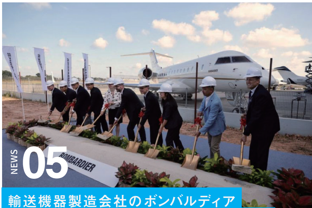
2019年2月27日に行われたボンバルディア シンガポール・サービスセンター拡張工事起工式の様子。
